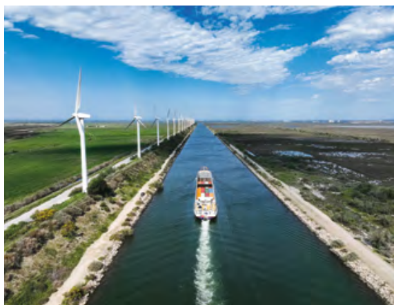
L'axe MeRS : une connexion fluide entre le port maritime de Marseille-Fos et les réseaux fluviaux européens. | The MeRS corridor: a seamless connection between the Marseille-Fos seaport and Europe's inland waterway networks.
