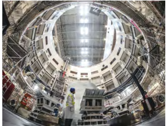
Vue de l'intérieur du cryostat situé dans la fosse du tokamak ITER, utilisé pour créer et confiner le plasma de fusion | View of the interior of the cryostat located in the pit of the ITER tokamak, used to create and confine fusion plasma.
